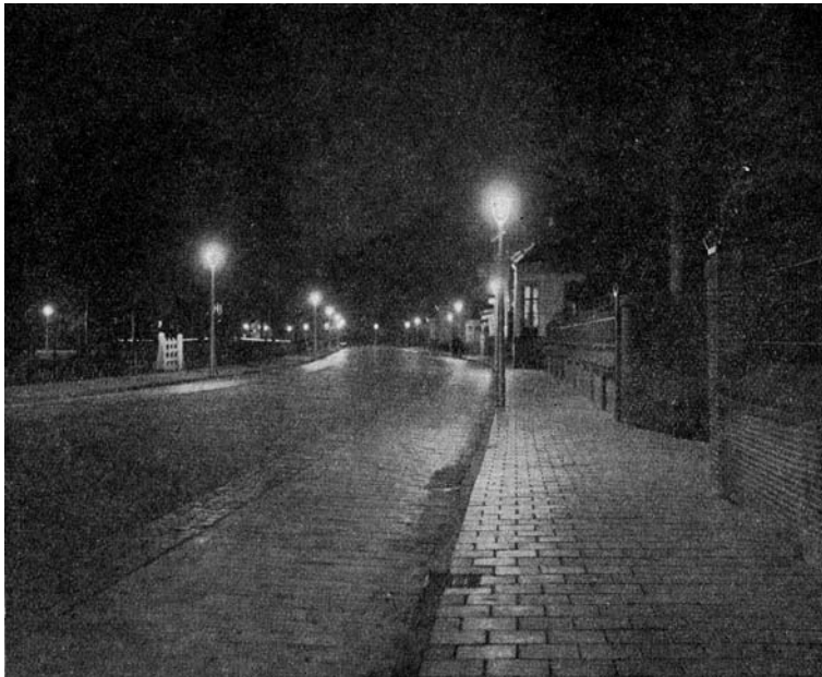
Fig. 24. Gelijkmatige wegdekverlichting met Blohm-ballons.
